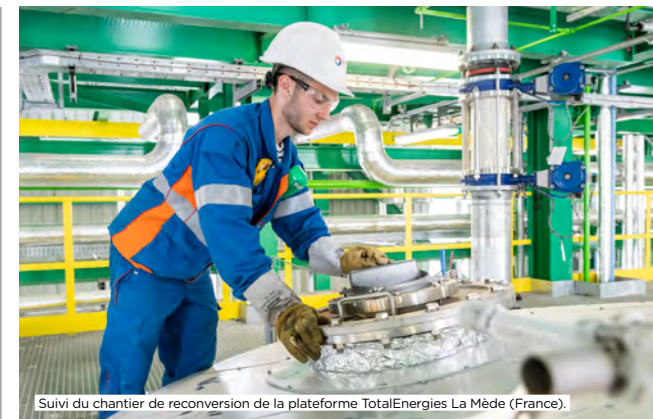
Suivi du chantier de reconversion de la plateforme TotalEnergies La Mède (France).
